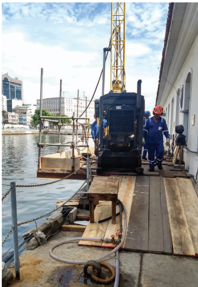
Realização de perfuração com equipamento apoiado em plataforma suspensa.
