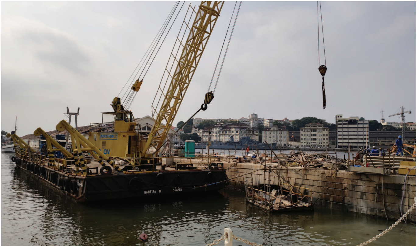
Balsa mobilizada no canteiro.
