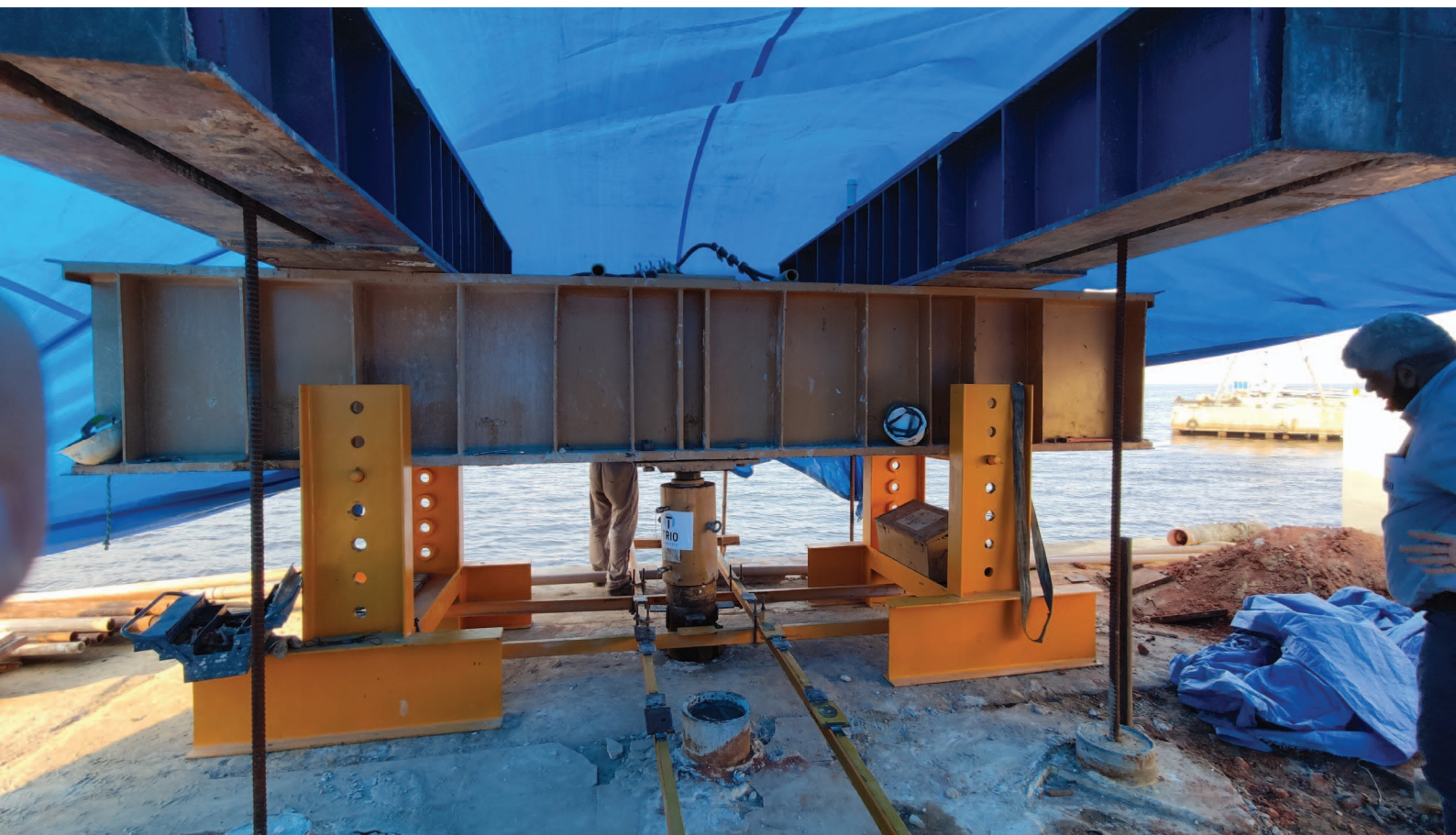
Atuador hidráulico e estrutura de reação para realização da prova de carga estática.
