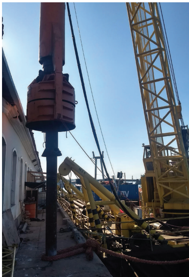
Balsa apoiando na realização de cravações.
