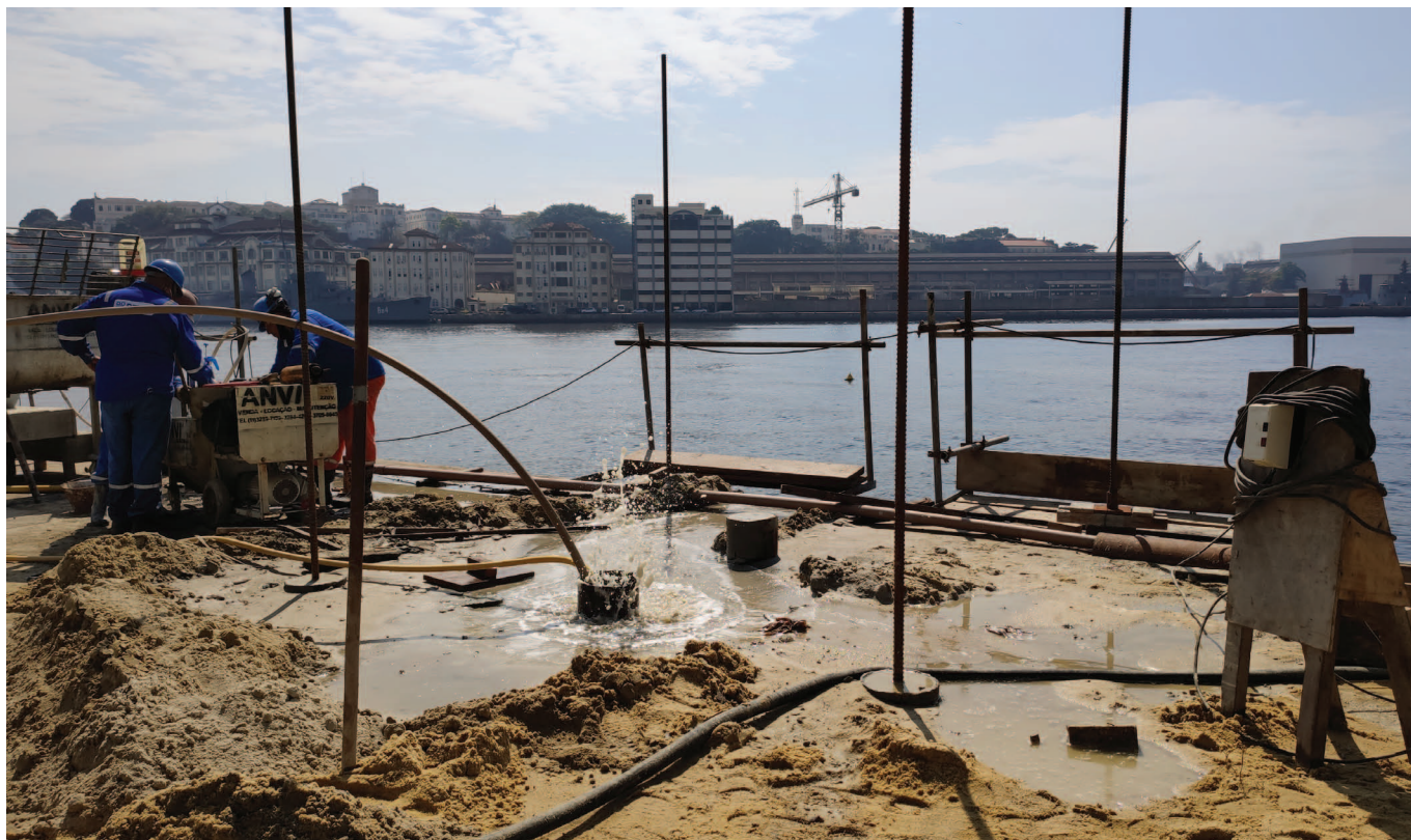
Realização de limpeza por circulação de água na extremidade de cravação da estaca, permitindo a ultrapassagem da cota de falsa nega.
