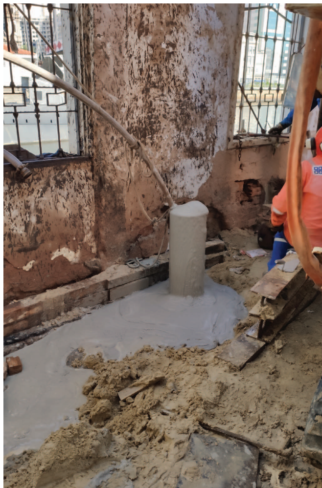
Execução de concretagem com argamassa na parte interna de estaca.
