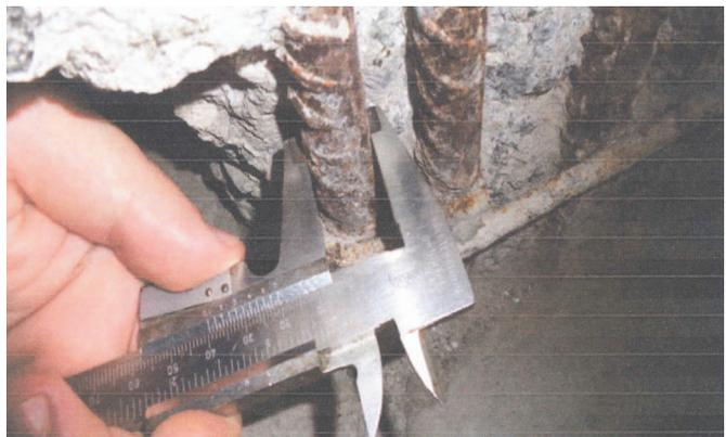
Figura 5 – Seção transversal da armadura longitudinal de um pilar. Fonte: fernandesgrossi.com.br
