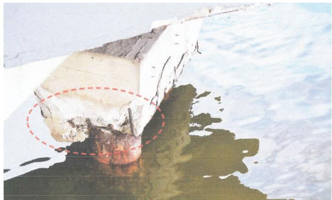
Figura 4 – Deslocamento do concreto adjacente. Fonte: gazetaonline.com.br
