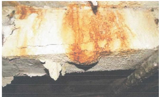
Figura 3 – Fase iniciação da corrosão. Fonte: axfiber.com.br
