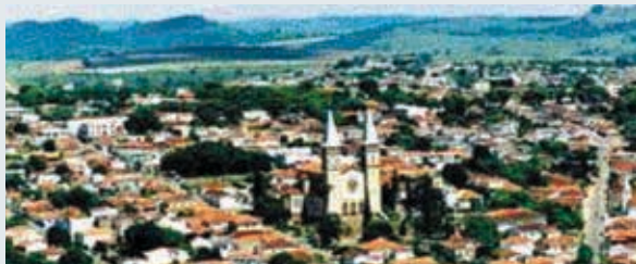
► Figura 2: Vista aérea do município mineiro de Guaxupé
