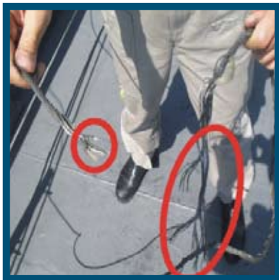
Ponto de ruptura do cabo de aço
