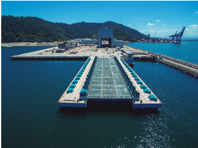
Figura 2: O shiplift será empregado no lançamento dos submarinos ao mar e no recolhimento para manutenção. Instalada em área marítima, a plataforma elevatória possui 110 m de comprimento por 20 m de largura e tem a capacidade de 8.000 t.
