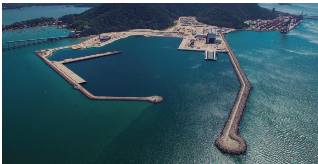
Figura 1: Vista aérea da Área Sul da Base Naval.
