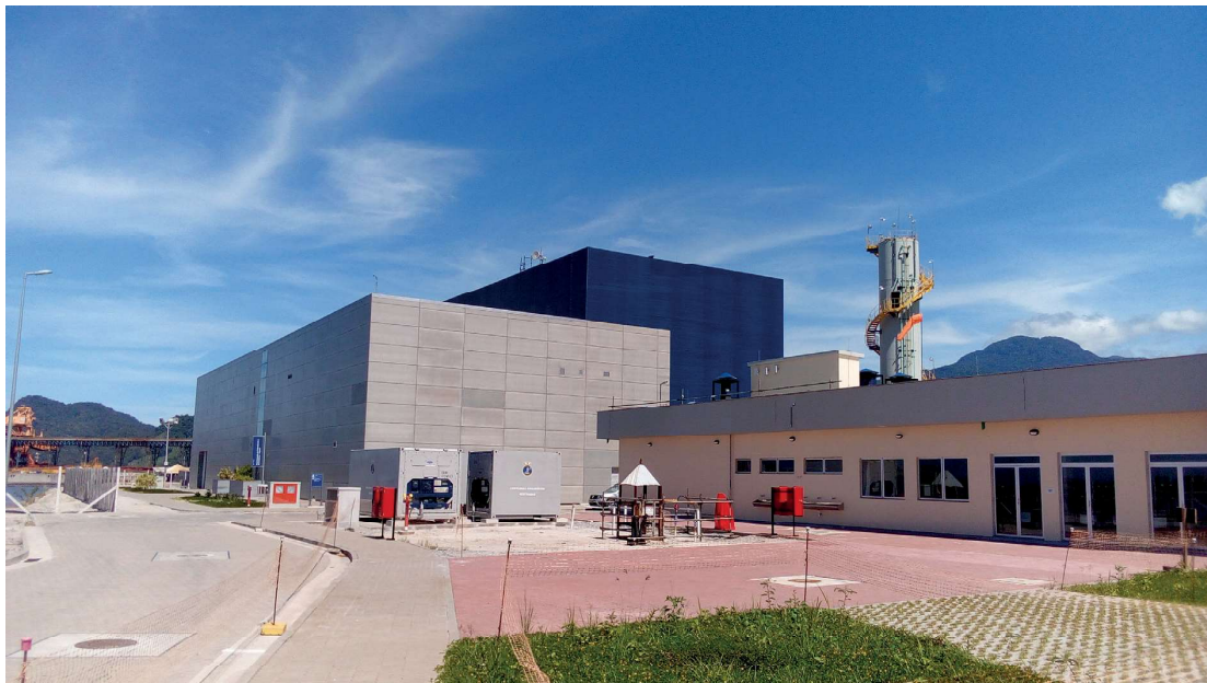
Figura 1 - Prédio do Departamento de Treinadores e Simuladores
