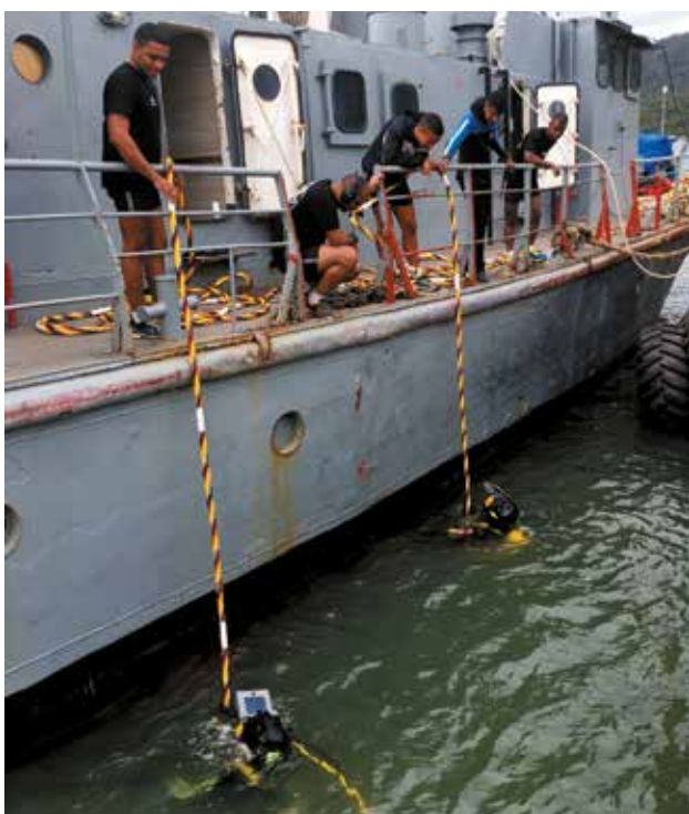
Figuras 7 e 8: Mergulhadores realizando corte e solda submarino em Navios da MB
