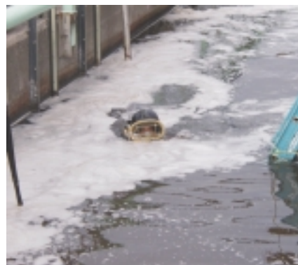
Mergulho em estação de tratamento de esgoto
