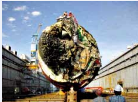
Fig 3: Danos estruturais com o acidente
