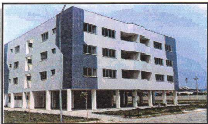
Bloco de apartamentos para Oficiais
