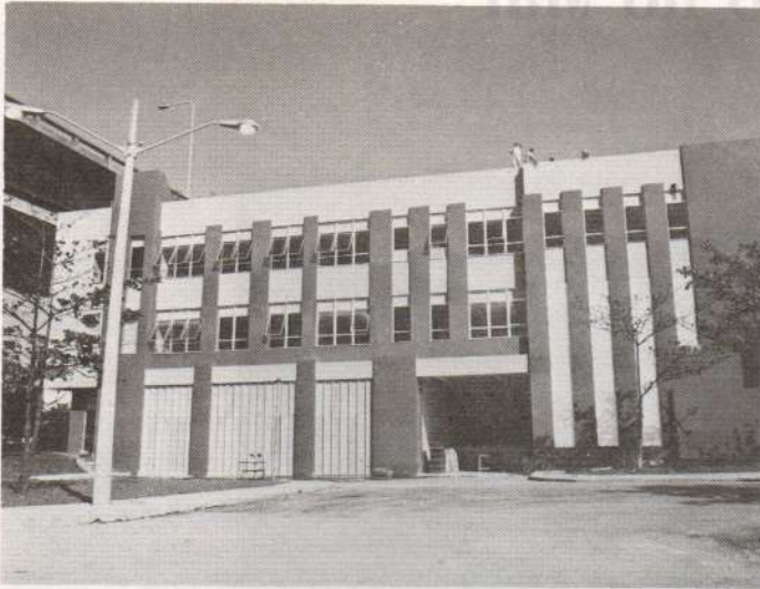
"Prédio do centro Hiperbárico em fase final de Construção"
