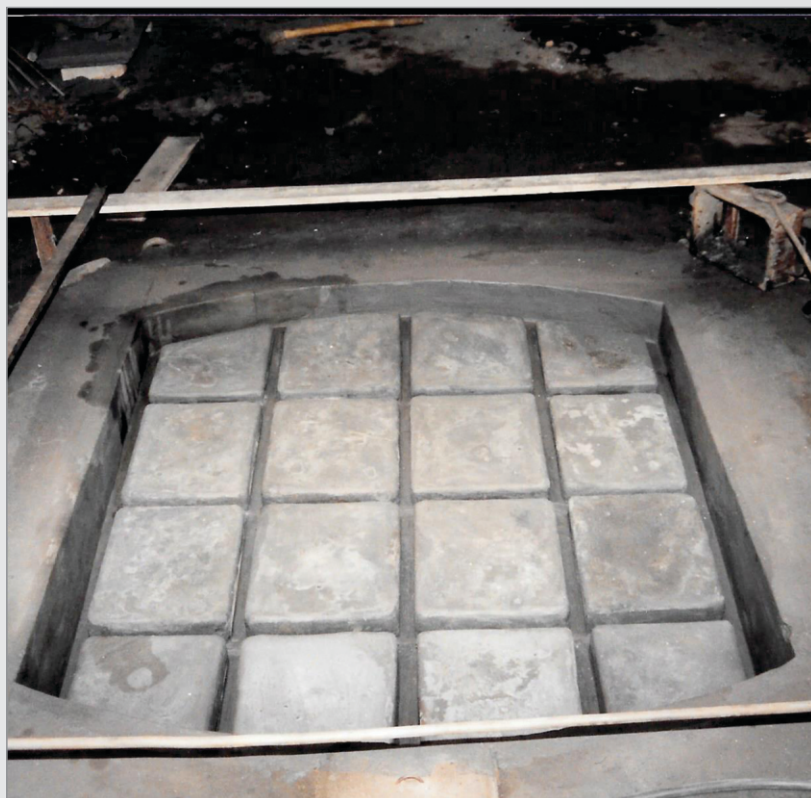
Foto 4 – Detalhe da “caixa de areia” (forma) para fundição da nova comporta.
