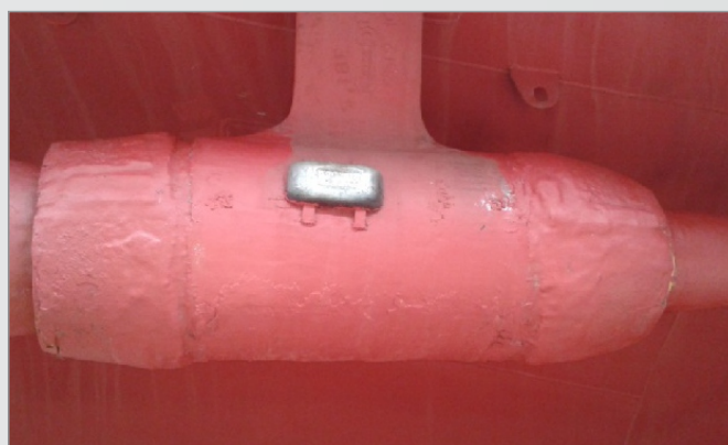
Foto 31 – Pintura e fixação de anodo de zinco.
