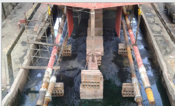
Foto 7 – Preparação para retirada das seções de eixo Expostas e Propulsoras.
