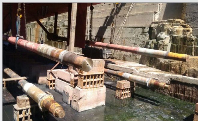
Foto 6 – Posicionamento das seções de eixo Expostas e Propulsoras para retirada do Dique.
