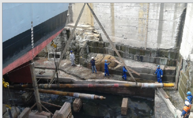
Foto 8 – Retirada das seções de eixo Expostas e Propulsoras do Dique.
