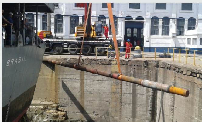
Foto 9 – Retirada das seções de eixo Expostas e Propulsoras do Dique.
