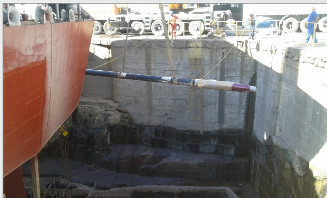
Foto 22 – Retorno das seções de eixo expostas e Propulsoras para o Dique.
