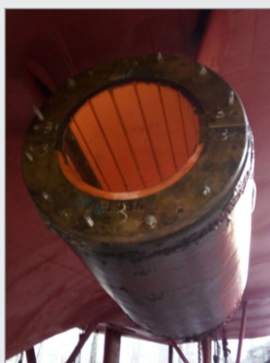
Foto 24 – Montagem da bucha THORDON no pé de galinha principal.
