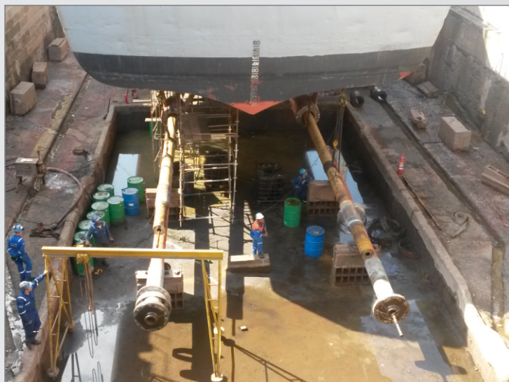
Foto 2 – Detalhes das quatro seções das linhas de eixo já puxadas, com as seções do propulsor apoiadas sobre os blocos do dique e as intermediárias sob talhas.
