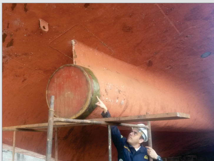
Foto 5 – Tamponamento estrutural do tubo telescópico de boreste.
