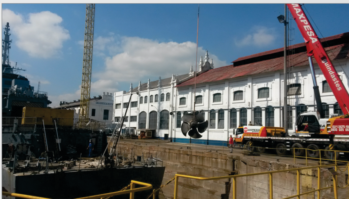
Foto 3 – Um dos hélices sendo içado por guindaste de grande capacidade contratado pela BNRJ.
