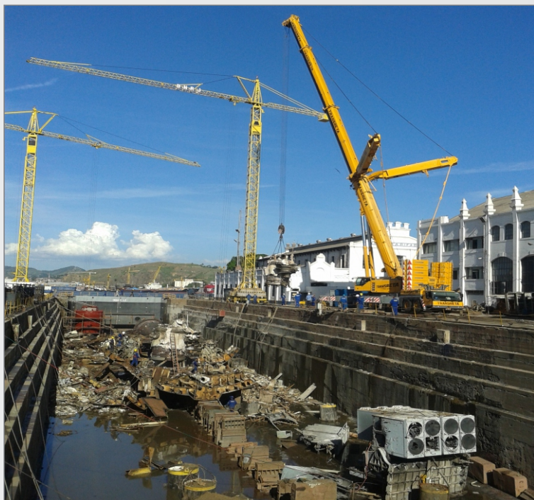
Foto 7 – Guindaste contratado de grande capacidade (para até 440t) retirando uma das caldeiras.
