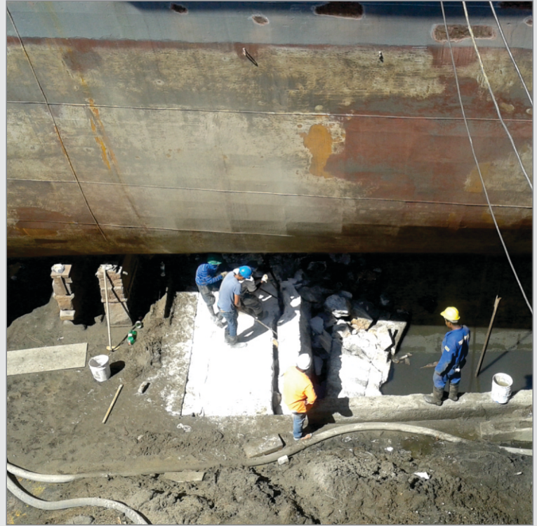
Início da demolição da rocha.
