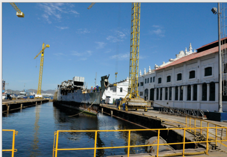
Foto 4 – Deslocamento em diagonal ao longo do dique, com a proa talingada ao chassi da grua.
