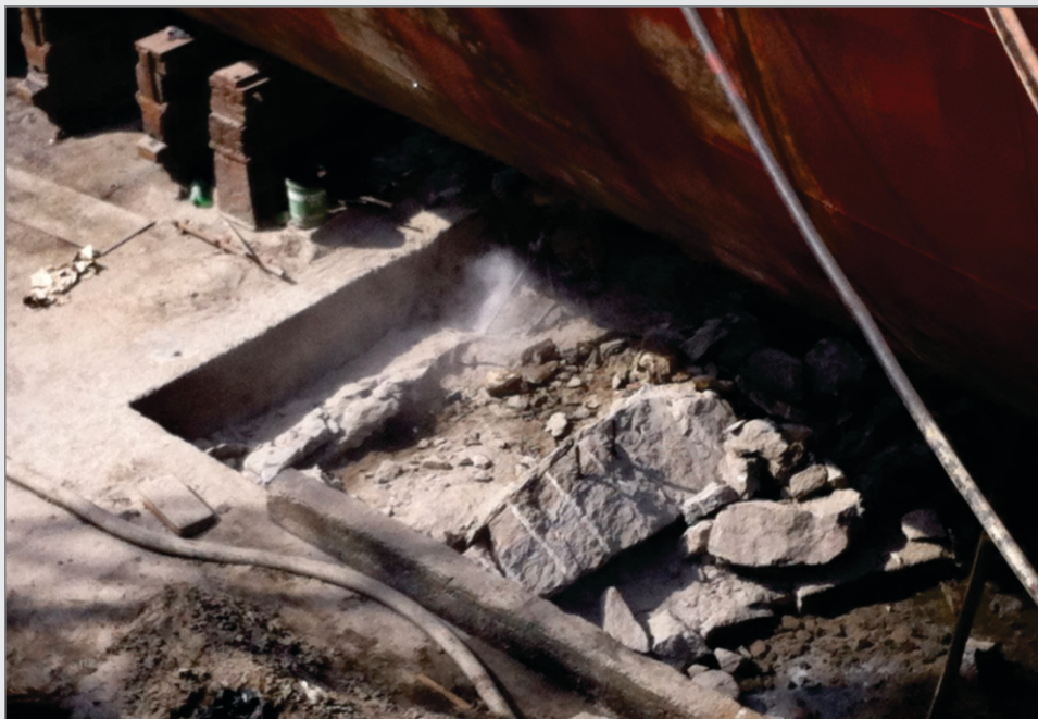
Demolição da rocha do fundo do dique com o NE docado sobre o fosso.
