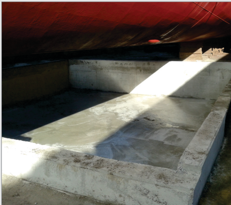
Concretagem do fosso concluída.
