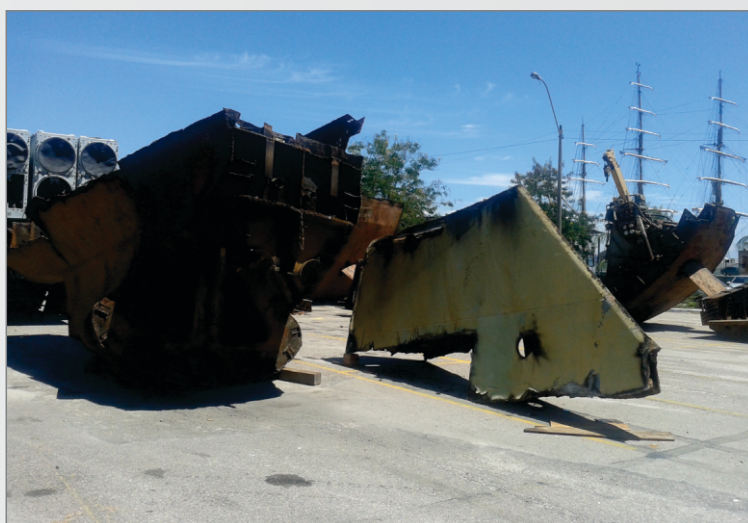
Foto 8 – Operação conjunta de dois guindastes sobre rodas da BNRJ para retirar o lançador de mísseis (20t) ASROC de cima do CavMec do CFN.
