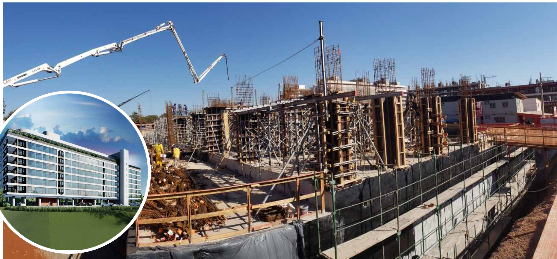
Foto da construção de MAI2023
