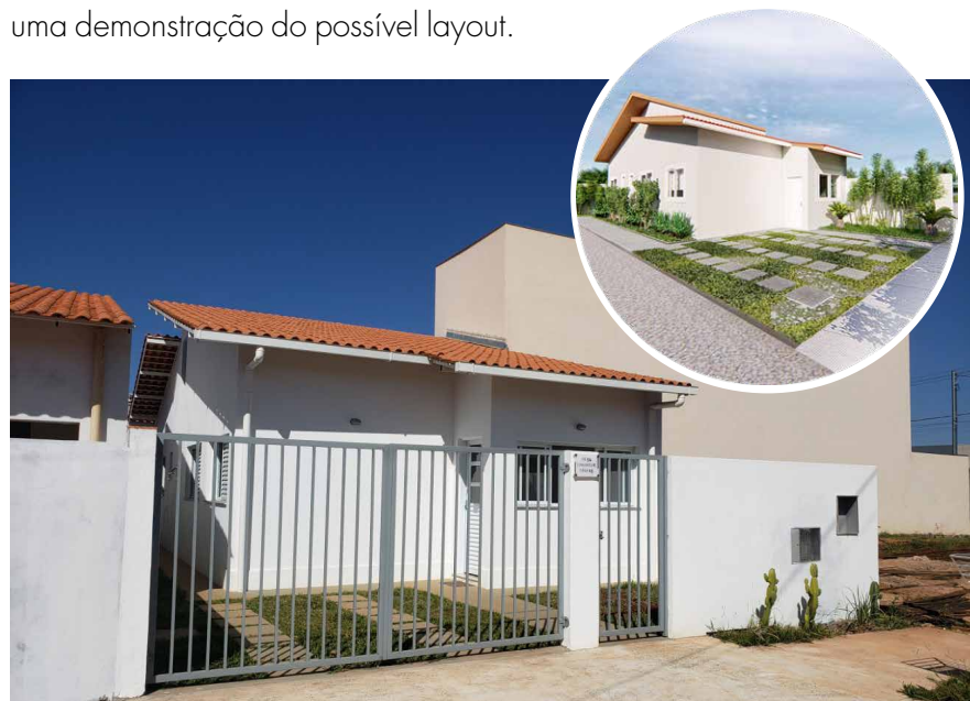
Foto da construção de MAI2023.
