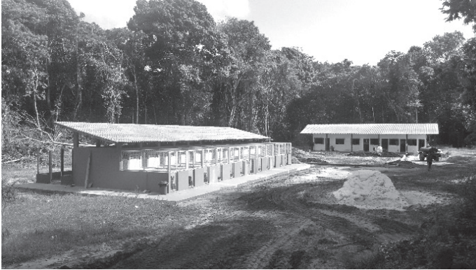
Finalização das obras do prédio administrativo e dos boxes dos cães
