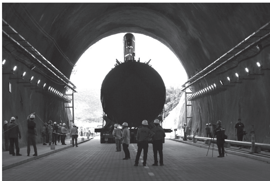
Figura 3 – Passagem no túnel para o elevador de navios
