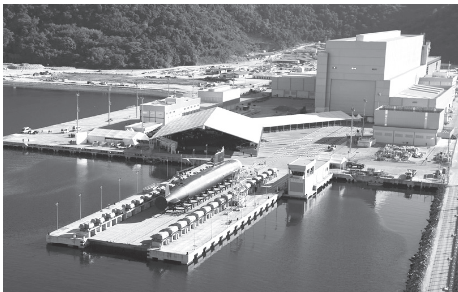
Estaleiro de construção na Base de Submarinos da Ilha da Madeira (BSIM)
