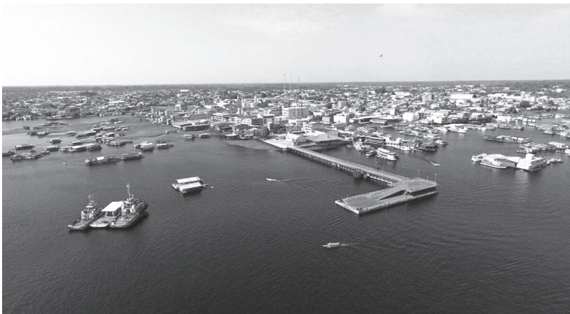
Figura 8 – Instalação Portuária Pública de Pequeno Porte (IP4)
