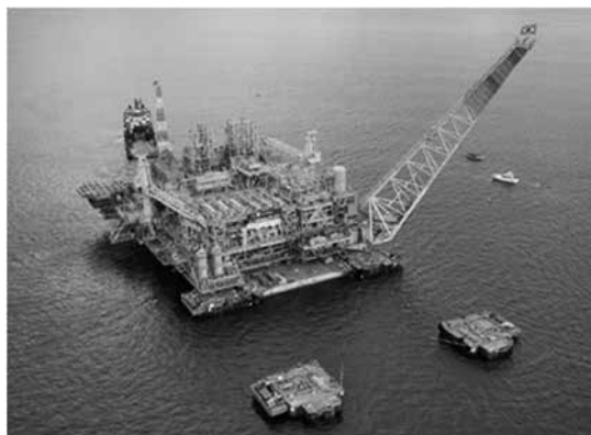
Figura 13- Plataforma de perfuração semissubmersível
