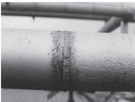
Figura 7 – Corrosão em torno de cordão de solda (Arruda, 2009)
