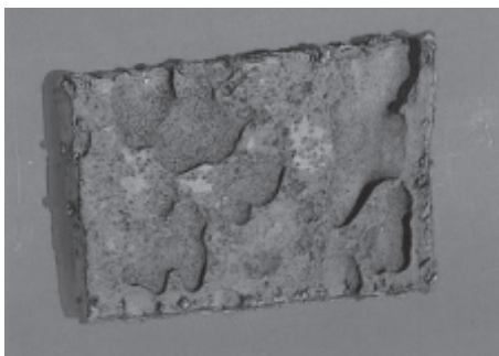
Figura 2 – Corrosão em Placas (Arruda, 2009)
