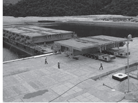
Desembarque dos módulos da plataforma elevatória no cais da área sul da Base Naval
