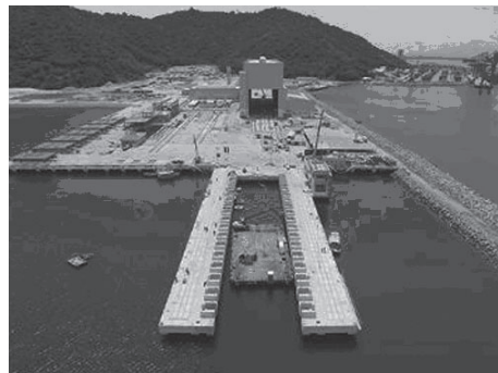
Estrutura do shiplift em construção
