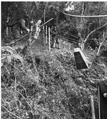
Serviço de engenharia sendo realizado nas elevações do Complexo Naval de Itaguaí
