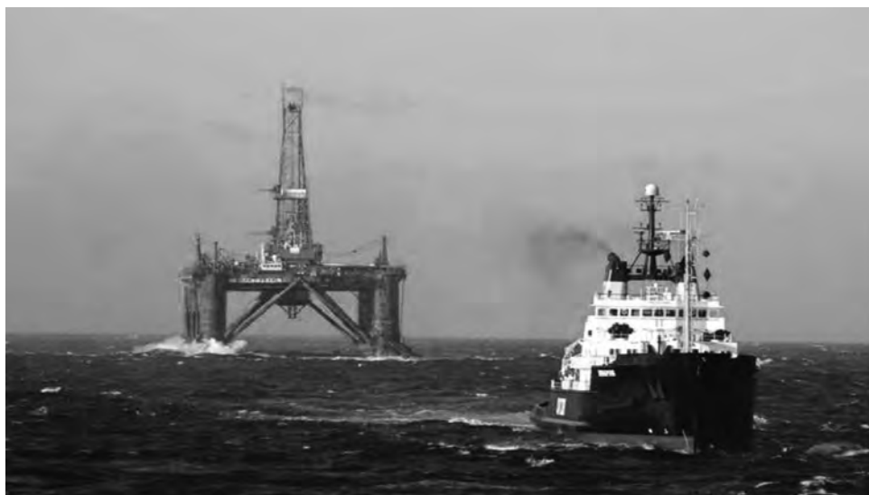
Plataforma de petróleo e navio de apoio offshore
