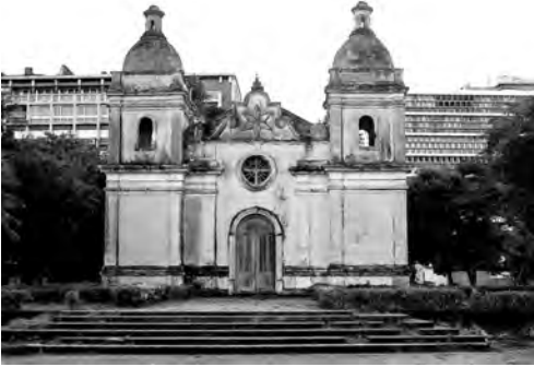
A Igreja de Nossa Senhora do Livramento, atualmente conhecida como Catedral Velha, em Quelimane, Moçambique, onde, em 1872, foi encontrado o Estandarte extraviado
