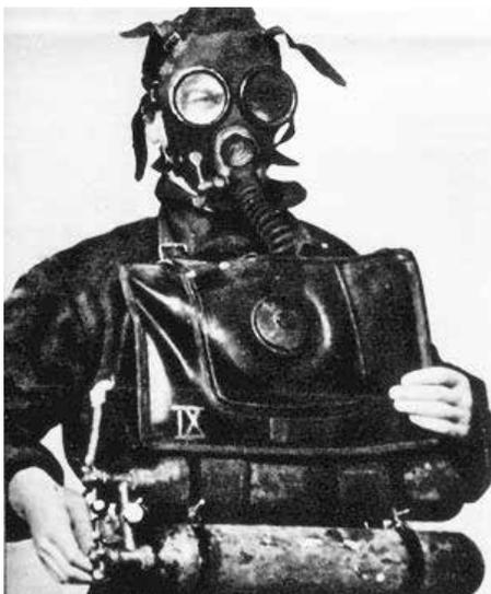
Fotografia 2: Operador da 10ª MAS equipado com o dispositivo de respiração subaquática ARO (*Auto Respiratore ad Ossigeno*) e o traje de mergulho Vestito Belloni (Fonte: BARBIERI, 2012, p. 28)
