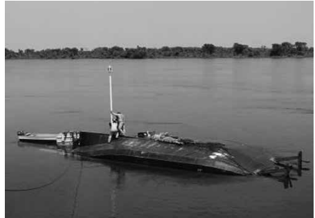
Instalação do farolete sobre o casco do Rebocador TNR 12
