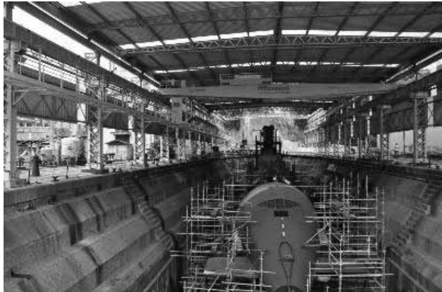
Dique Santa Cruz
