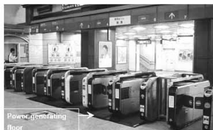
Figura 14 – Colheita de energia a partir de um piso: (a) Mecanismo de geração de energia por intermédio de uma caminhada; (b) Gerador de energia experimental a partir dos pés de passageiros por ocasião da saída da estação Norte Marunouchi, Tokyo
