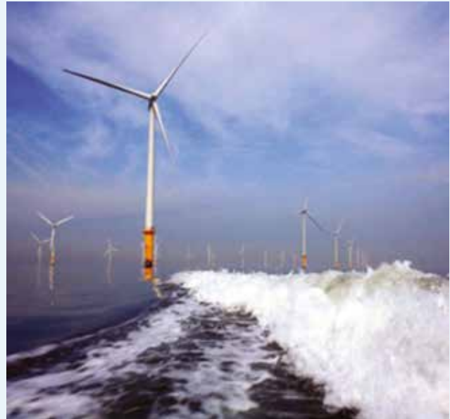
Parque de geração de energia eólica
