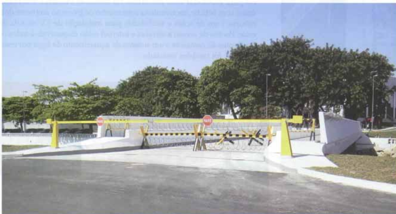
Nova ponte de acesso
