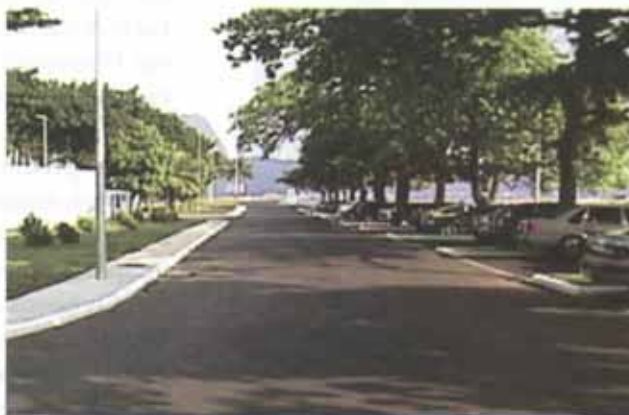
Alameda Marcílio Dias após as obras de infraestrutura e em processo de urbanização
