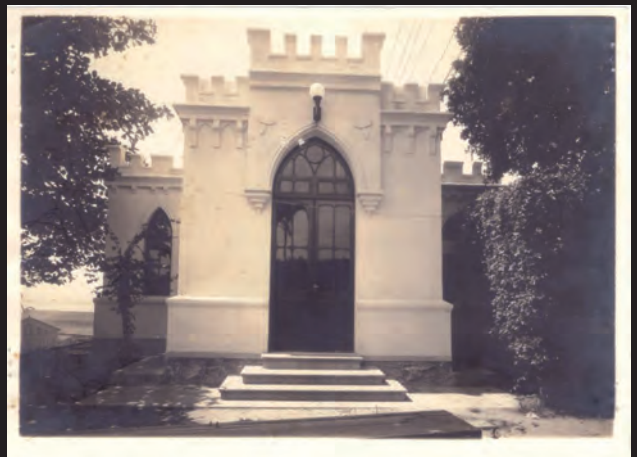
Figura 16 - Prédio da Capela e Necrotério do HCM.
