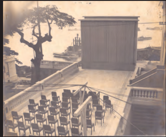
Figura 18 - Cinema do HCM, atualmente transformado em auditório.
