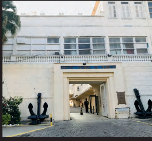
Figura 14 - HCM - Pórtico atual.
