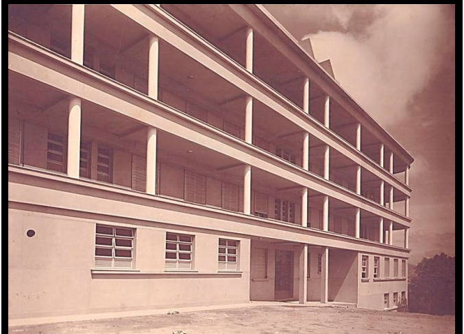
Figura 8 – Pavilhão Dr. Carlos Frederico, varandas
