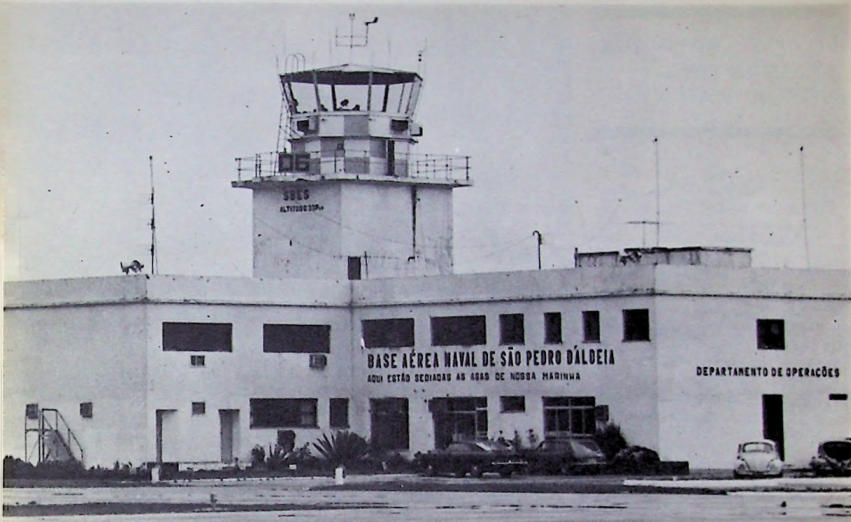
Torre de comando e prédio da Base Aérea Naval de São Pedro da Aldeia
