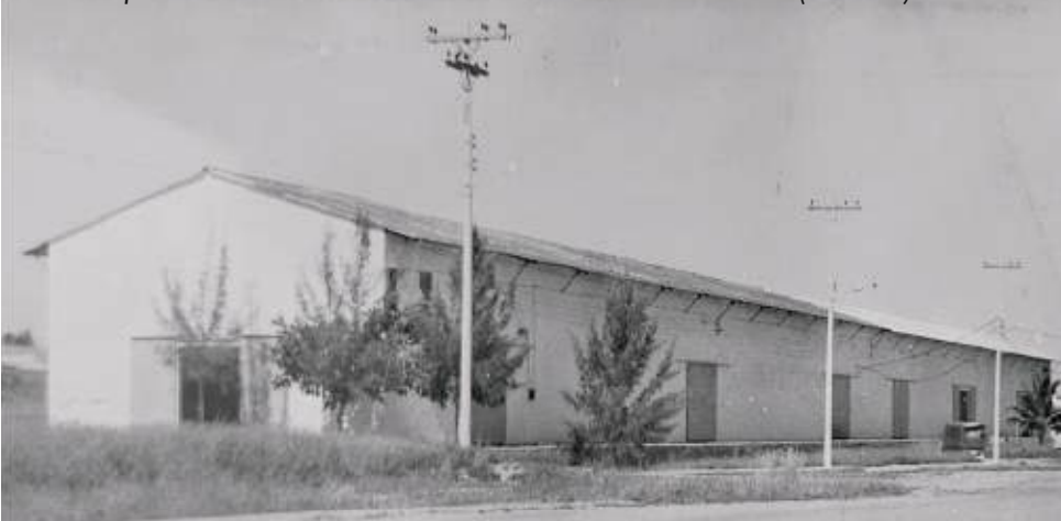
1966 - Depósito Secundário da Base Aérea Naval de São Pedro da Aldeia (BAeNSPA)
