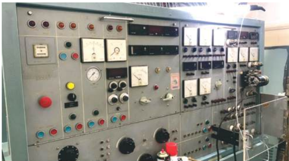
Bancada de teste de geradores
