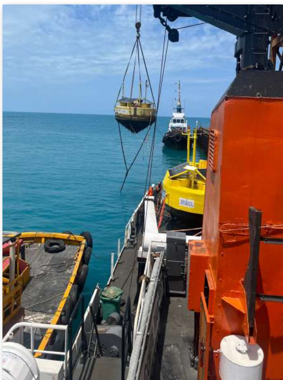
Montagem dispositivo para lançamento da boia
