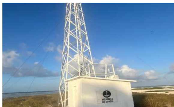
Tratamento e pintura do Farol Atol das Rocas
