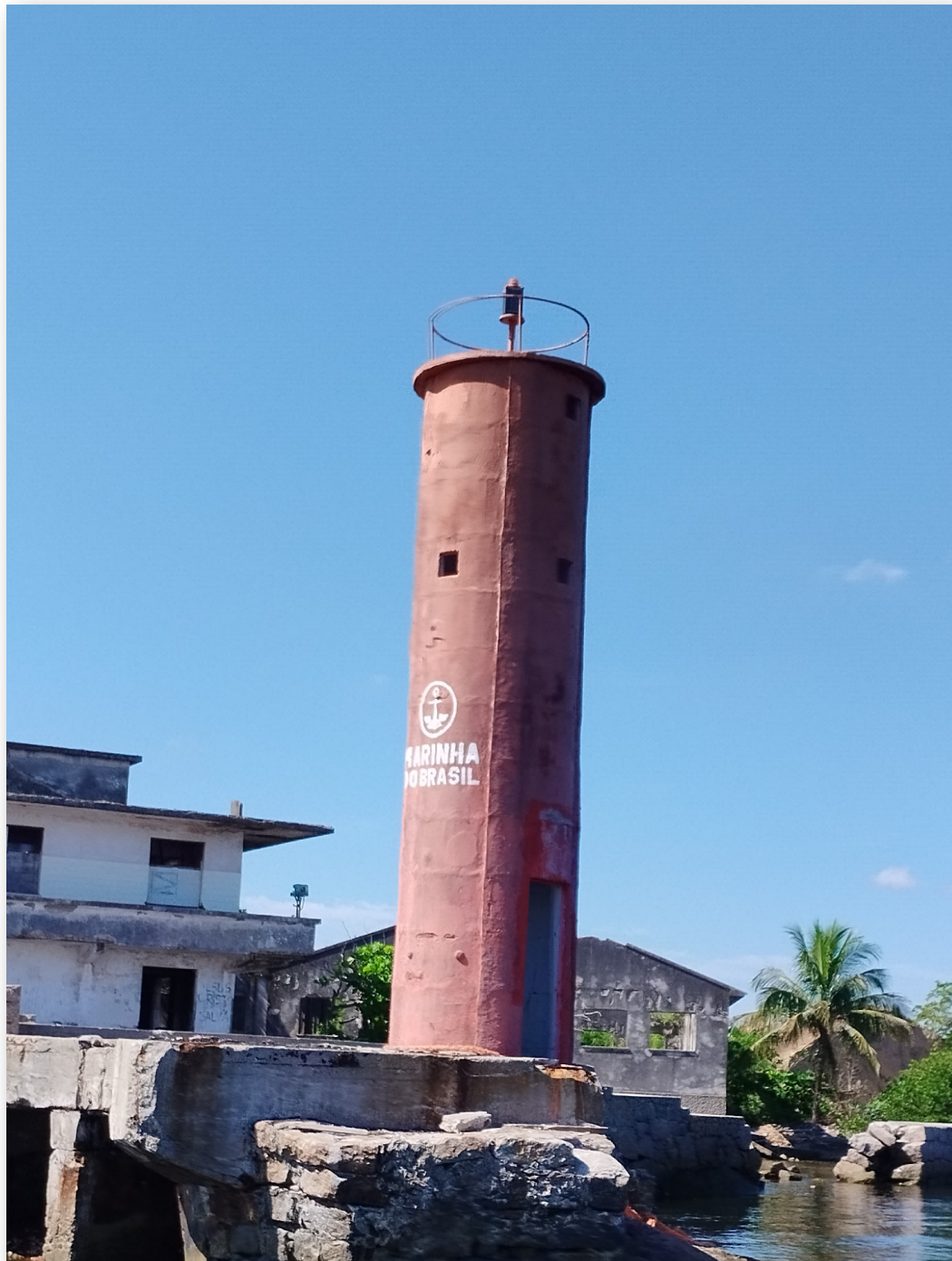
Figura 2- Extrato da Lista de Faróis (2024) Fte Itapacis é uma estrutura de alvenaria, composta por uma torre cilíndrica de concreto armado, na cor encarnada, estando posicionado na altitude de 10 metros, com altura de sua estrutura de 7 metros.
