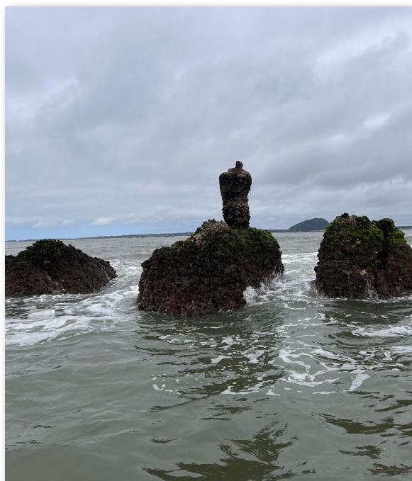
Restauração da Baliza Itacolumins (Antes da manutenção)
