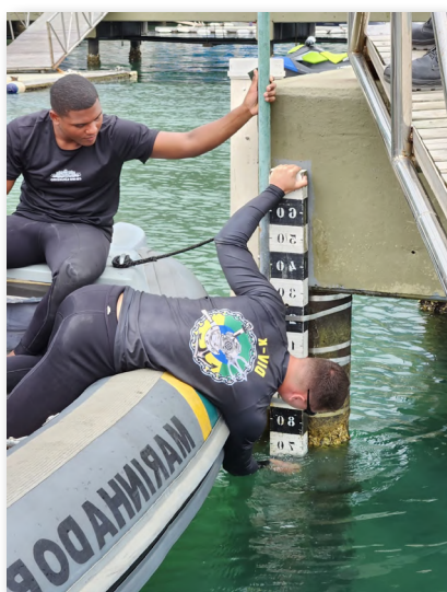
Faina de fixação da régua.
