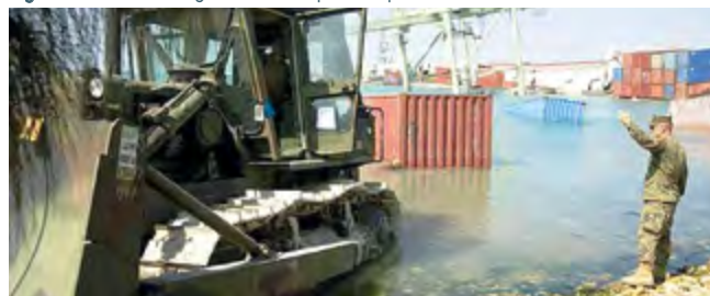
Figura 2: Meios de engenharia no reparo do porto
