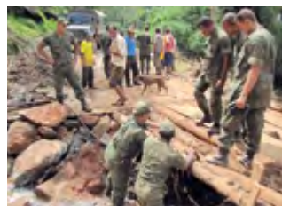
Figura 6: Reconstrução de ponte em Nova Friburgo
