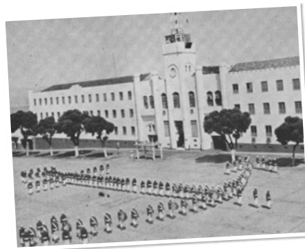
Pátio central da Fortaleza São José (1978)
