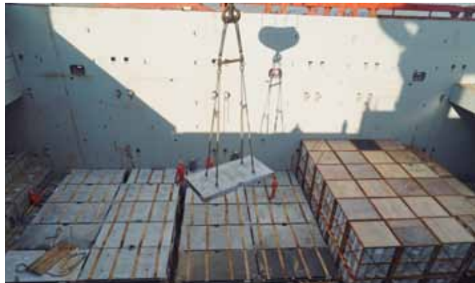
O material das fundações da nova EACF a bordo totalizou 17.000 toneladas
