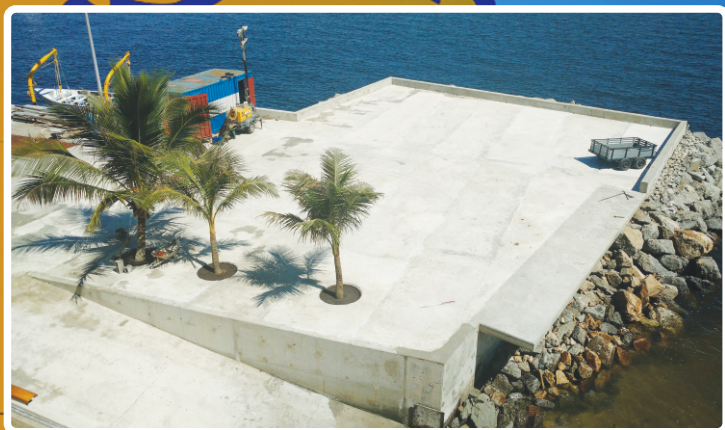
Enrocamento para Ampliação do Cais da Garagem de Barcos da Escola Naval (EN)
