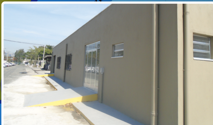
Novo Posto de Distribuição de Uniformes (PDU) da Base de Abastecimento da Marinha no Rio de Janeiro (BAMRJ)
