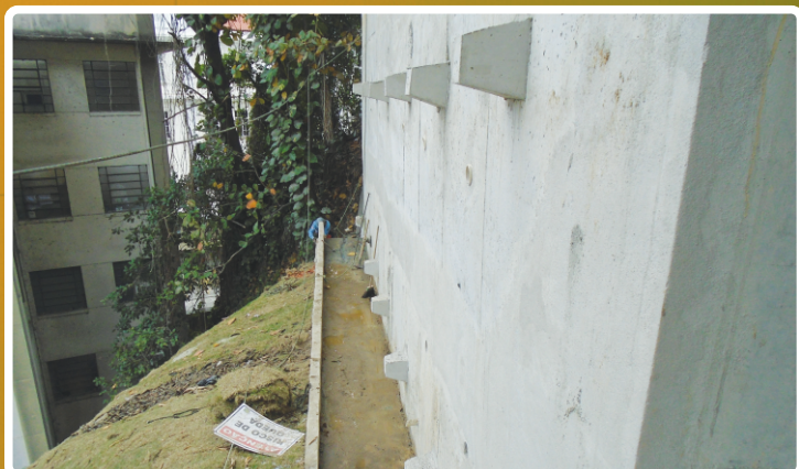
Contenção da Encosta do Batalhão Naval (BtINav), situada no Arsenal de Marinha do Rio de Janeiro (AMRJ)
