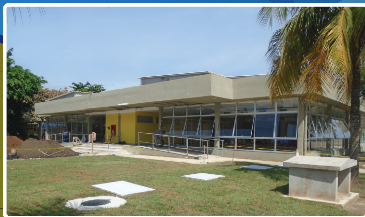
Construção do Novo Rancho da Base de Abastecimento da Marinha no Rio de Janeiro (BAMRJ)
