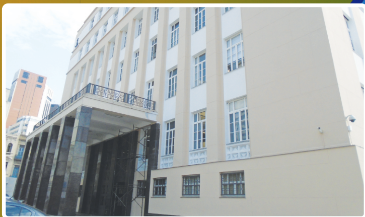
Recuperação e Pintura da Fachada do Edifício Almirante Tamandaré (Com1ºDN)
