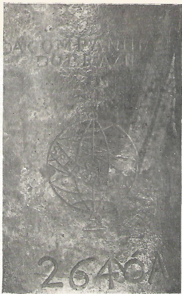
Foto 47 — Detalhe da peça de artilharia da figura 13 com a inscrição: DA COMPANHIA G l DO BRAZIL. Abaixo a esfera armilar com a frase SPERO IN DEO. Um pouco mais abaixo desta o número 2640 A que é o peso da peça em arráteis.
