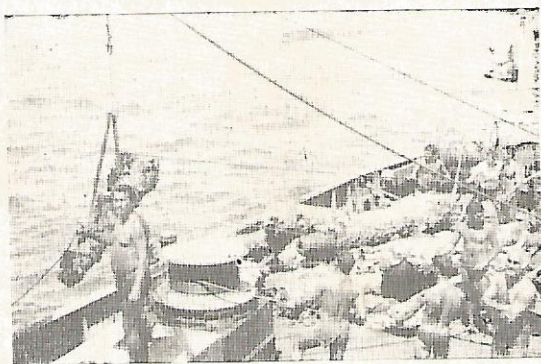
Foto 2 — Retirada de parte da artilharia do Galeão Sacramento , por um dos guindastes do N.S.S. Gastão Moutinho.
