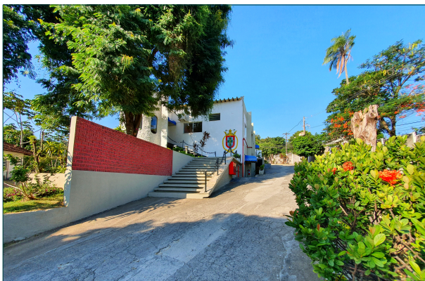
UISM, prédio do comando.
