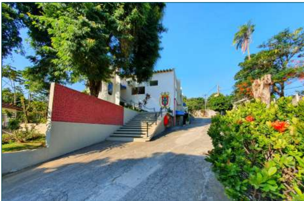
UISM, prédio do comando.
