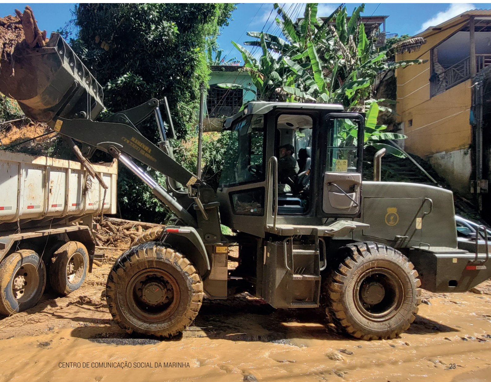
Desobstruções de vias utilizando retroescavadeira e caminhões do Corpo de Fuzileiros Navais
