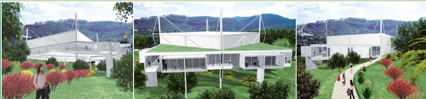
Centro de Convenções Eldorado Village: Estrutura metálica, lajes pré-moldadas e divisórias internas leves. (1)
