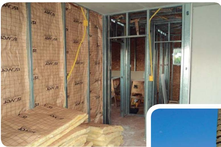
Paredes divisórias em *dry-wall* com lã de vidro
