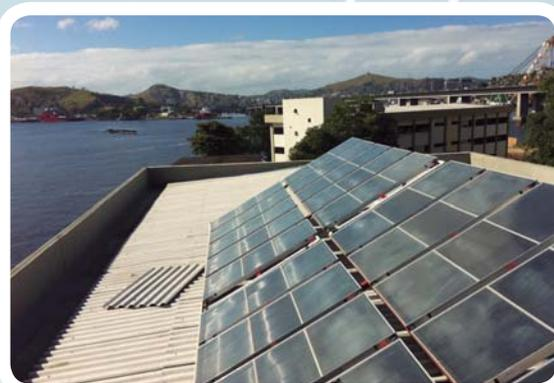
Um sistema de aquecimento de água por energia solar foi instalado na cobertura do prédio, cujas obras foram concluídas em agosto de 2011.
