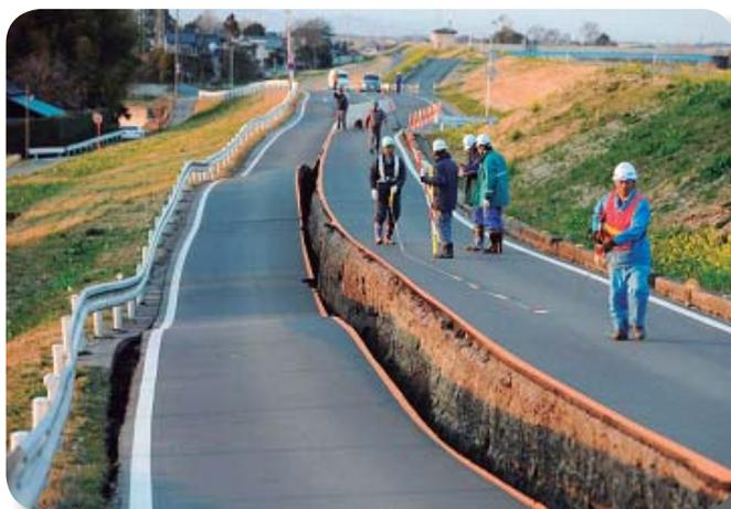
**Figura 6** - Consequência da liquefação do solo ocorrida sob uma estrada em Saitama, Japão, por ocasião do terremoto de 11 de março de 2011.
