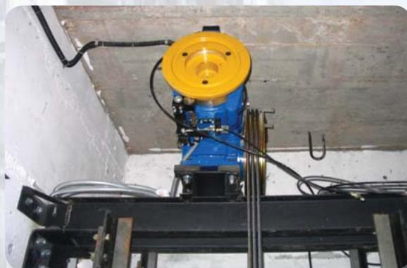
Figura 5 – Elevador sem casa de máquina – Fixação da máquina de tração (FERREIRA, 2010)
