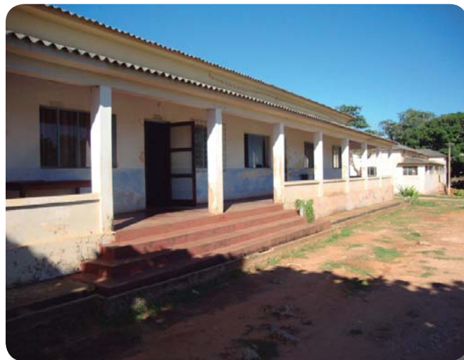
Figura 2 - Vista parcial do Prédio do Comando
