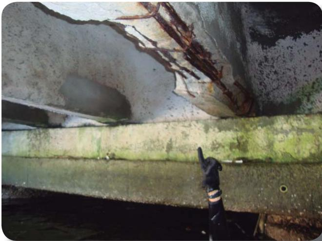
Figura 10 - Armadura da superestrutura de um píer apresentando elevado grau de corrosão.
