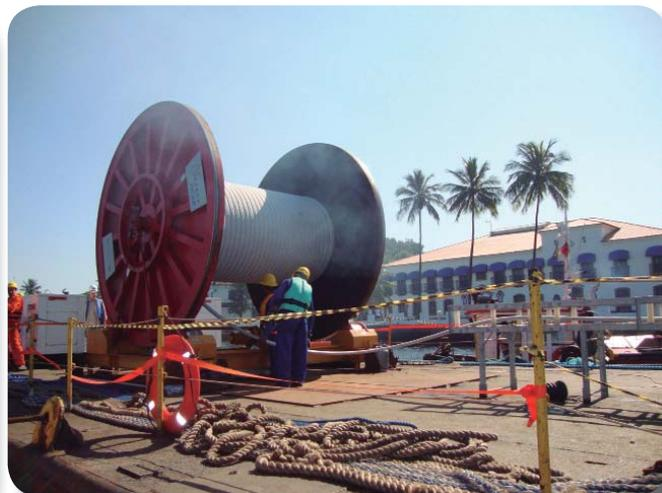
Figura 13 - Atividade de lançamento do cabo elétrico submarino do CIAW.
