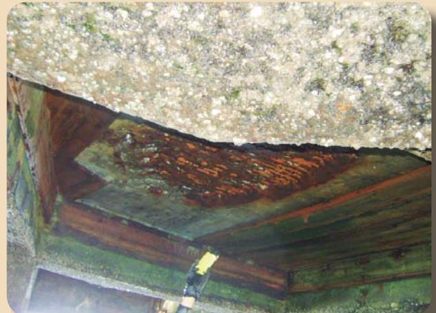
Figura 7 - Armadura da superestrutura do píer, apresentando elevado grau de corrosão.
