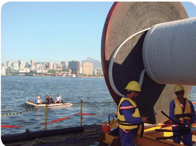
Figura 12 - Mergulhadores na fiscalização do lançamento e instalação do cabo elétrico submarino do CIAW.
