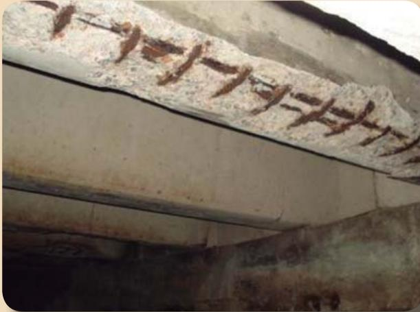
Figura 6 - Armadura da superestrutura de um píer apresentando sinais de corrosão devido à exposição direta ao ambiente marítimo e ausência de proteção.
